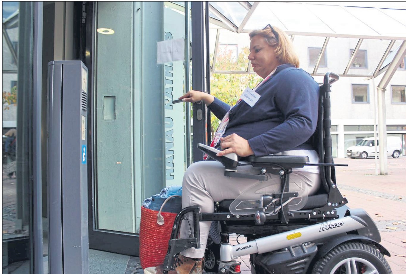
Von wegen barrierefrei: Der Zugang zum Rathaus-Verwaltungsbau ist für Menschen im Rollstuhl oder für Eltern mit Kinderwagen erschwert. Sie passen nicht durch die Drehtür. ■ Fotos: Spindler
